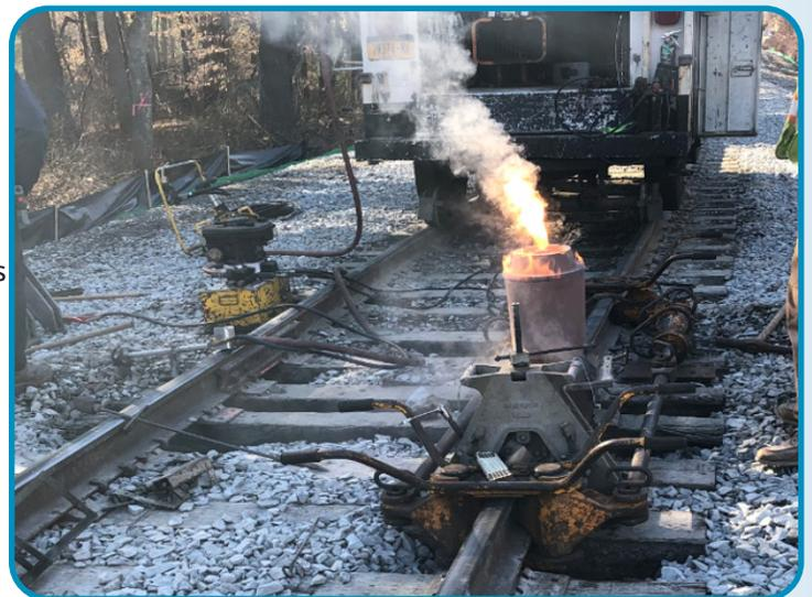
Foto de soldadura de vía en una alcantarilla en Taunton
