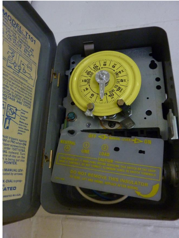
Photo 6 – Timeclock for Exhaust Fan
