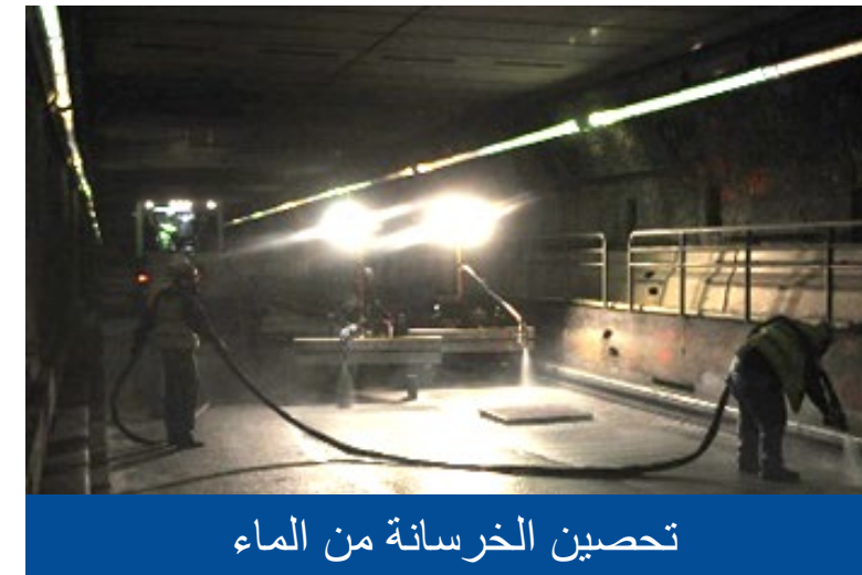
هدم الخرسانة بالماء
