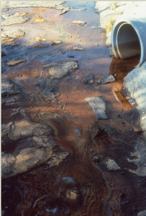
(Pie de foto: Desembocadura de drenaje pluvial — Foto del personal, 1985 / Storm drain outfall — Staff Photo, 1985)
