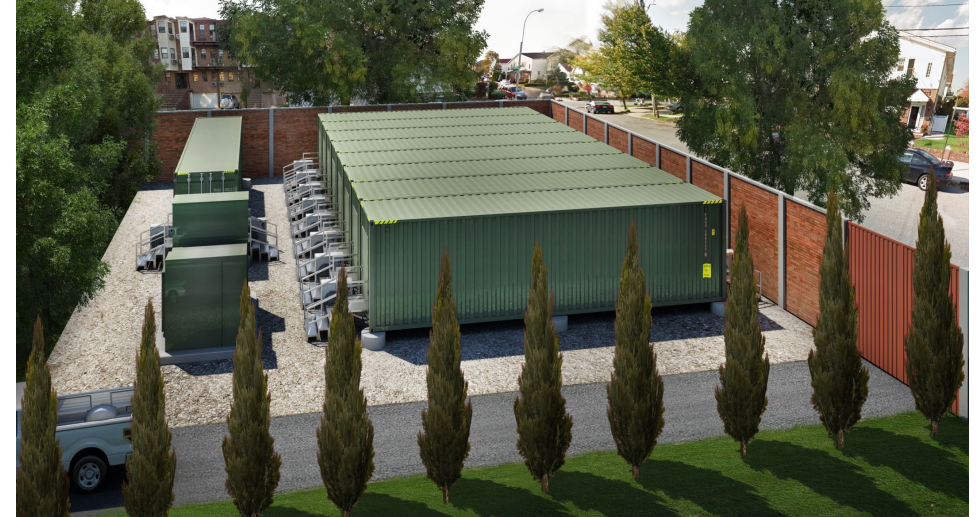
Source: Con Edison
