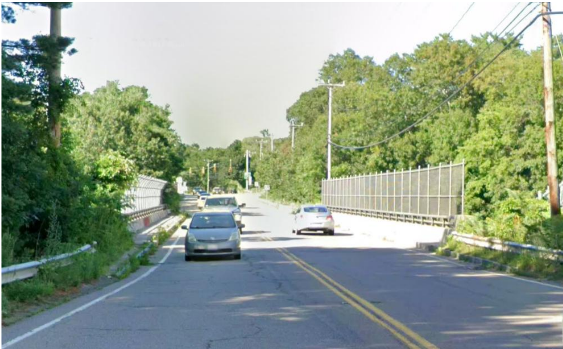
Figura 2: Situación actual mirando hacia el norte desde el puente hacia Ocean Hill Drive.
