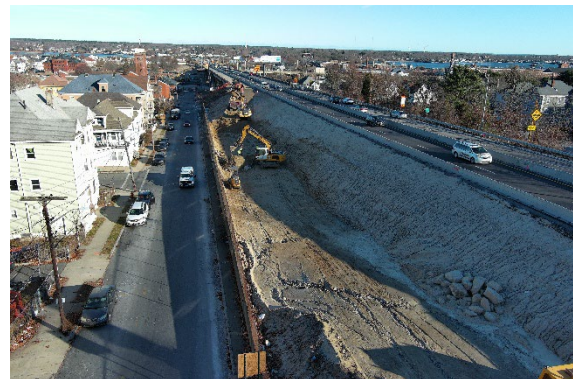
Imagem 4. Escavação ao longo da Rampa A
