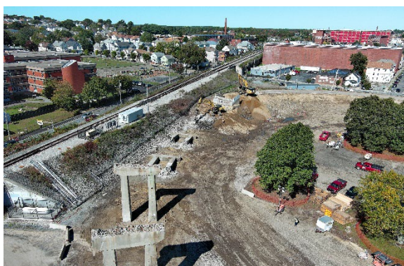
Imagem 3. Demolição da Rampa C
