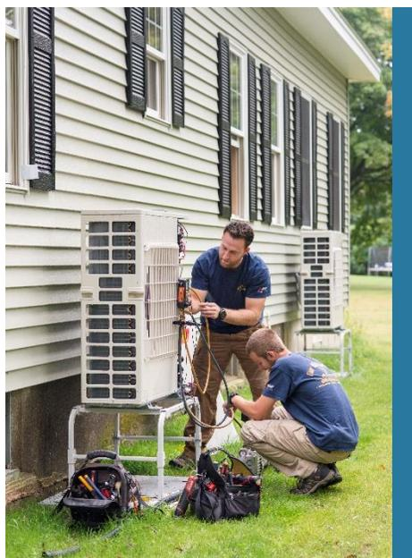
**Foto 5. Dois técnicos de HVAC instalando uma bomba de calor**
