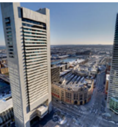
鳥瞰聯邦儲備銀行大樓和南站一景
