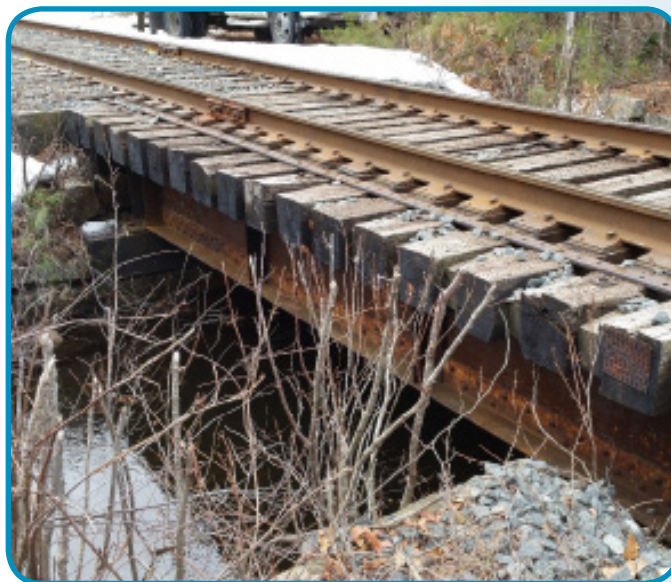
Esta Cotley River Bridge é uma das 4 pontes que será substituída como parte das acções preliminares do Projecto.
