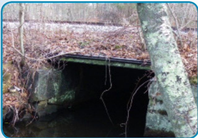
MassDOT actualizará algunas alcantarillas y puentes como parte de la obra Etapa 1.
