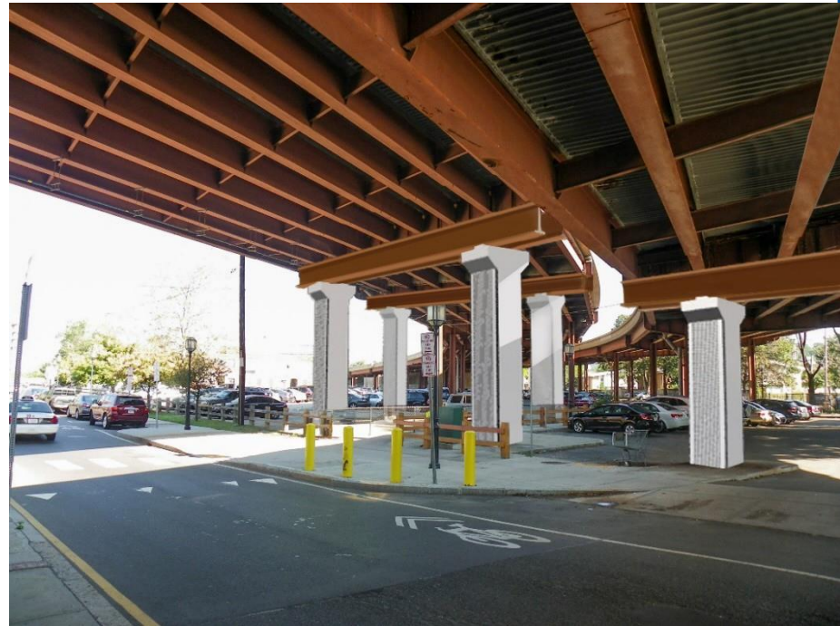
REPRESENTACIÓN DE SOPORTES TÍPICOS PROPUESTOS 'RETROFIT'
