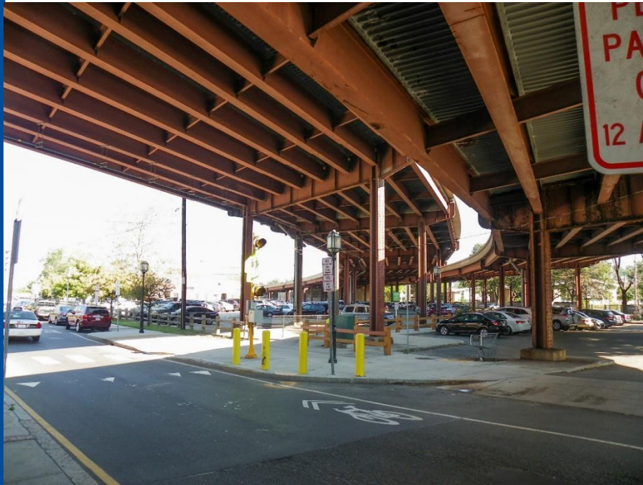
VISTA DE SOPORTES TÍPICOS EXISTENTES
