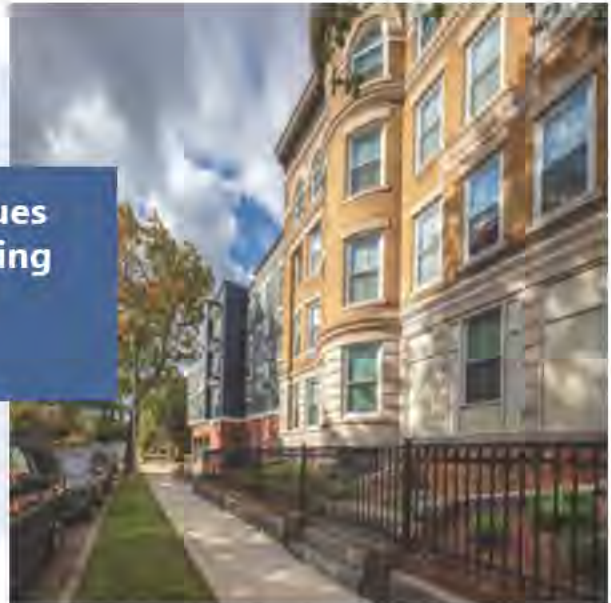
Library Commons – Holyoke, MA
