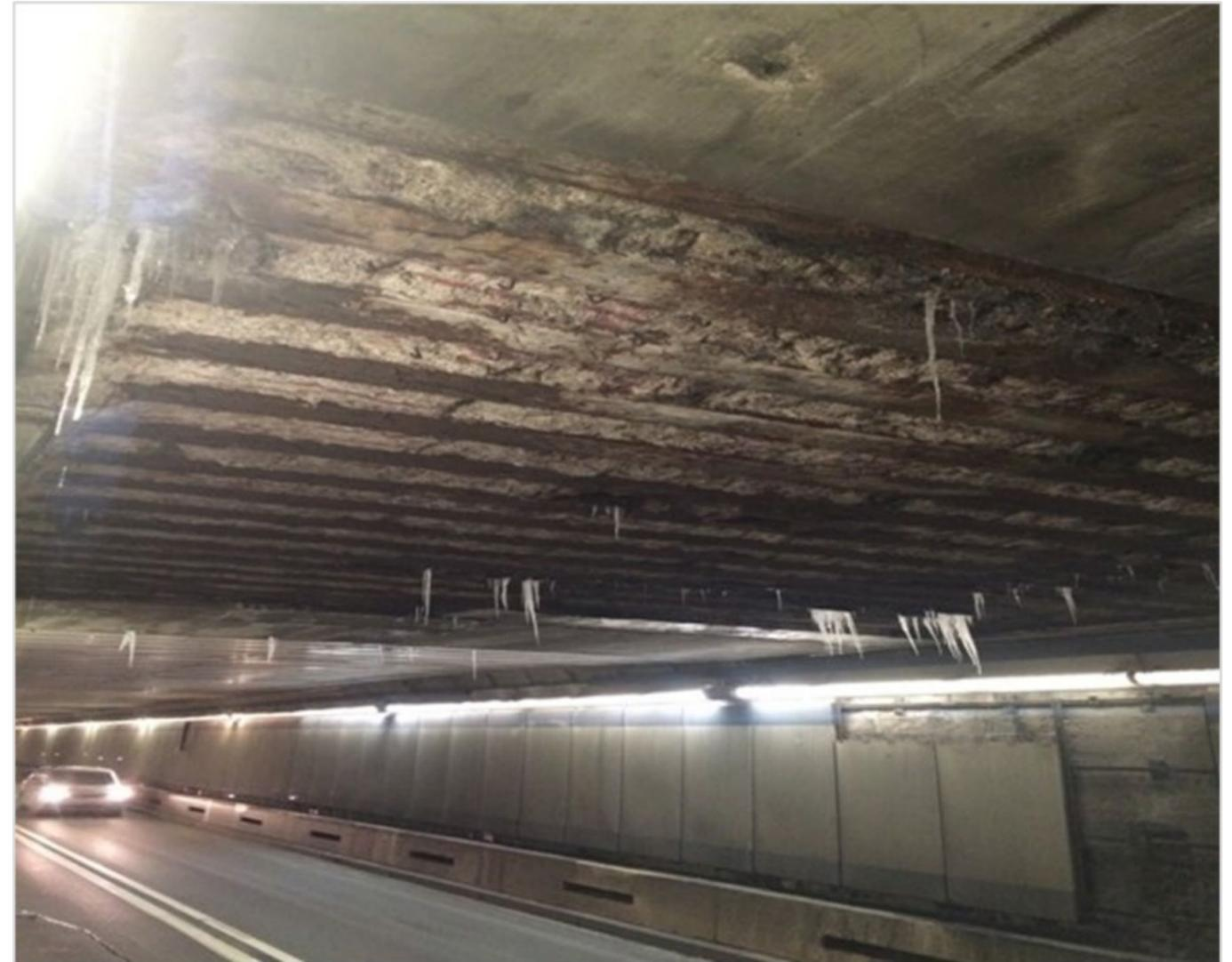
Hormigón despalillado, armadura corroída y vigas de soporte oxidadas
