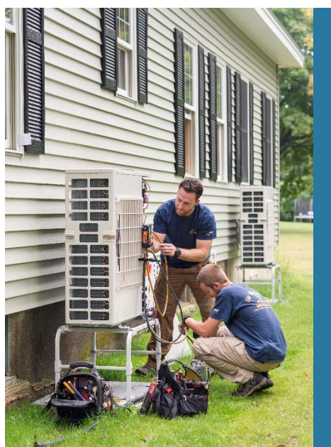
Hình ảnh 5. Hai Kỹ Thuật Viên HVAC lắp đặt Máy Bơm Nhiệt
