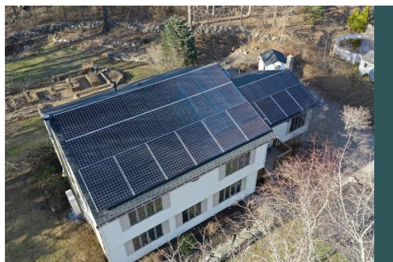
Hình ảnh 12. Lắp đặt hệ thống điện mặt trời trên mái nhà
