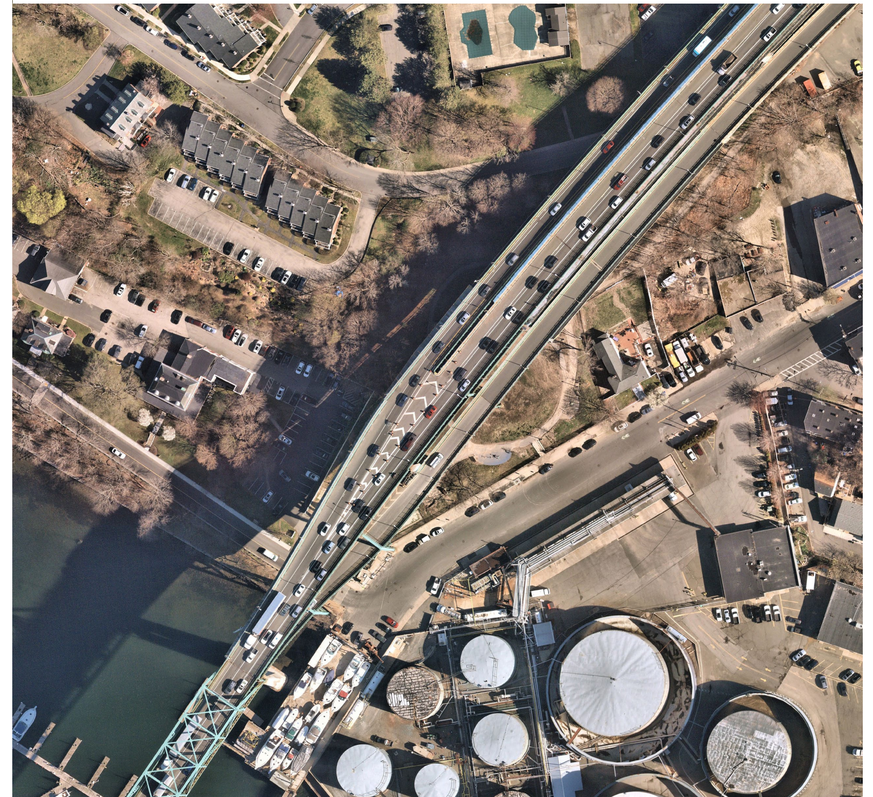
Rampa de acceso sur en Everett Street (Puente Tobin)
