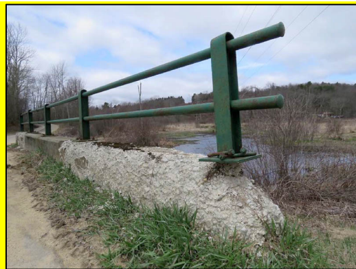
(d) Extreme Stage of Damage
